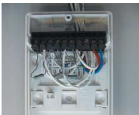
Traditionel montering med modstande
