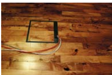
Gulvboks vist monteret i trægulv
