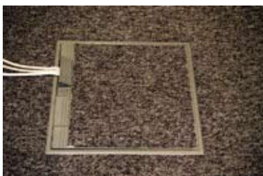
Gulvboks vist monteret i gulv med gulvtæppe
